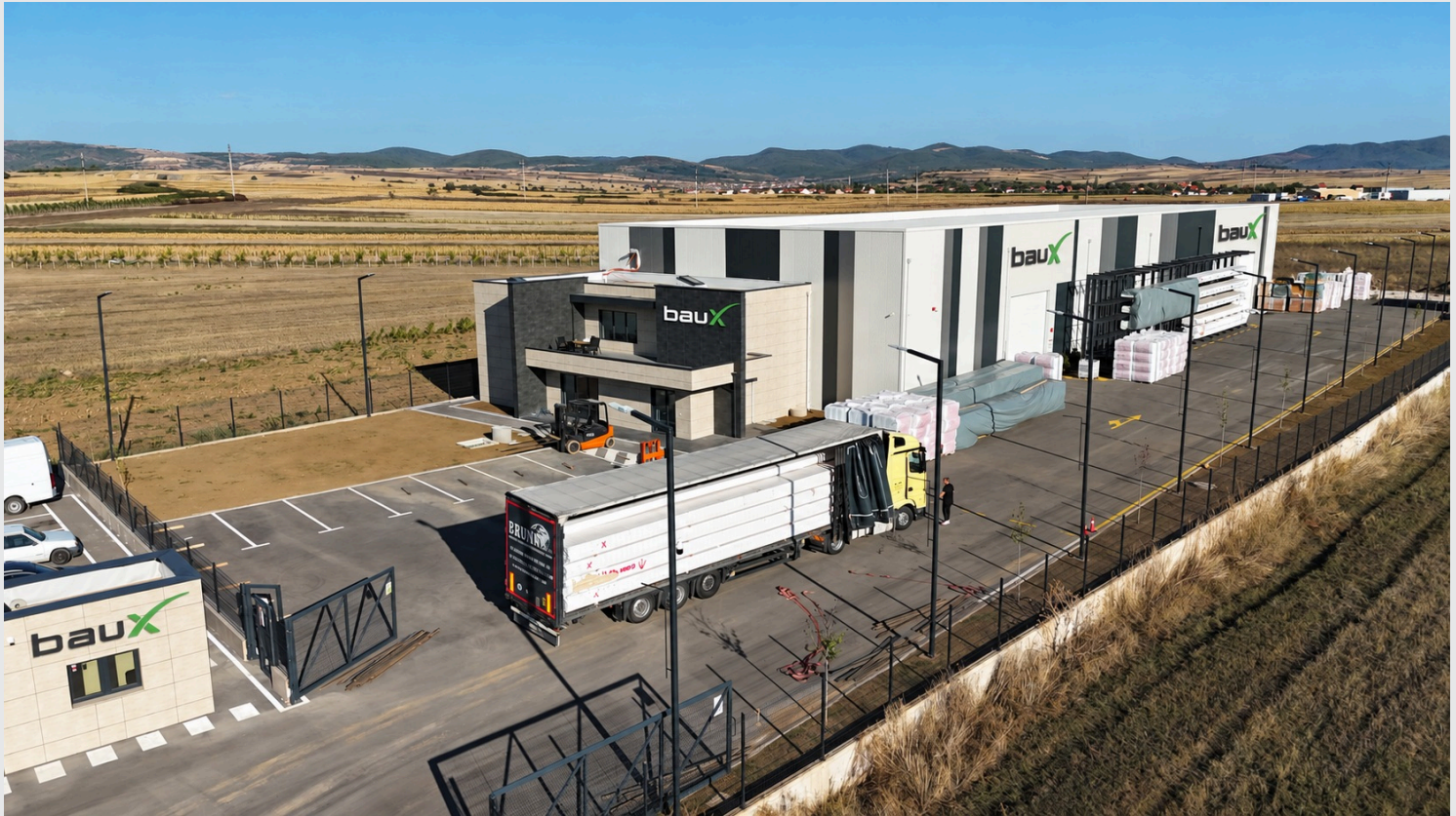
Produktionsstätte mit Fertigungshalle, Lagerbereichen und Verladung.
